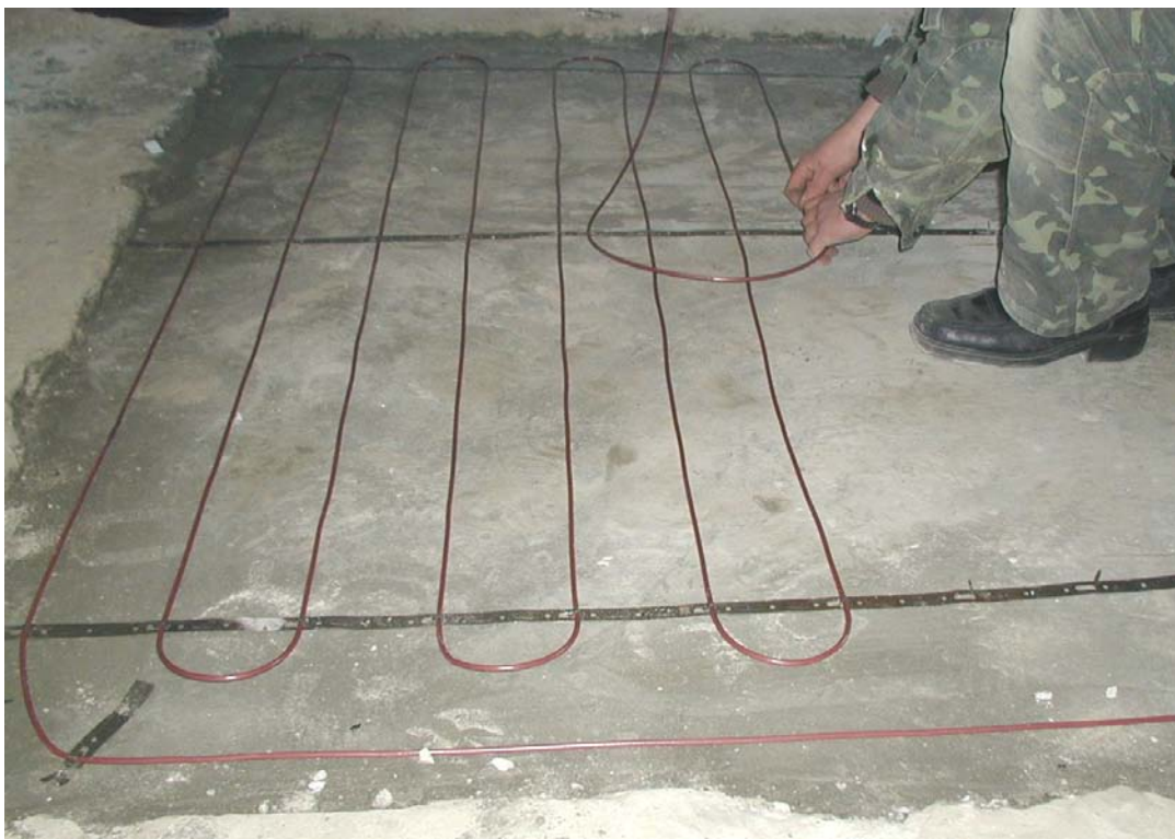
Рис.3. Монтаж нагревательного кабеля
