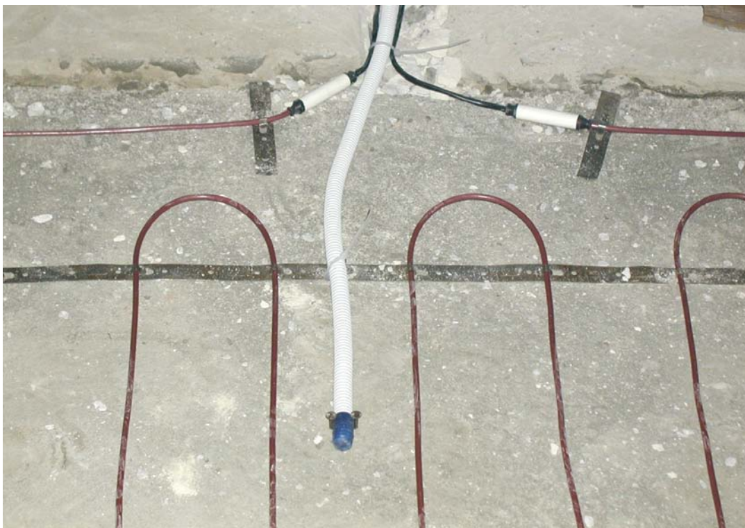
Рис.4. Расположение датчика и соединительных муфт
