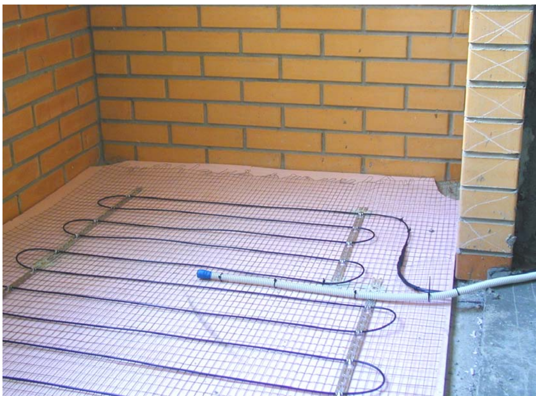
Рис. 6. На теплоизоляционный материал уложена металлическая сетка. Нагревательный кабель крепится к сетке при помощи монтажной ленты. На снимке видны гофротрубка с датчиком и соединительная муфта кабеля.
