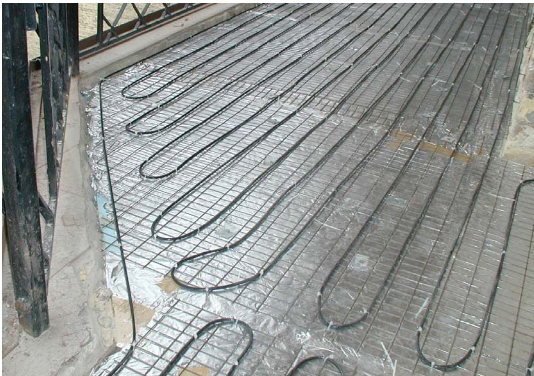
Рис.5. Крепление нагревательного кабеля к металлической сетке, уложенной поверх теплоизоляционного материала (в данном случае применен фольгированный теплоизолятор). Нагревательный кабель крепится к сетке при помощи пластмассовых хомутиков.
