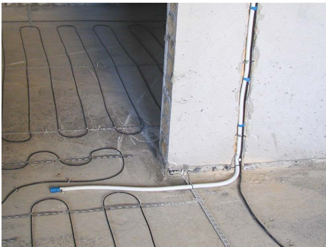
Рис. 10. Гофротрубка с датчиком и монтажные концы нагревательного кабеля закладываются в штрабу в стене и подводятся к регулятору (месту его установки).
