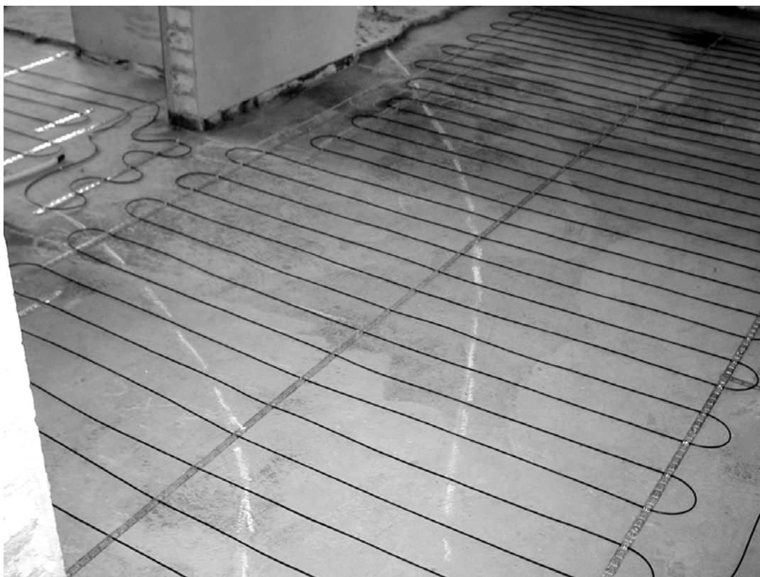
Рис. 9. До начала укладки кабеля на полу отмечаются трассы скрытых коммуникаций.
